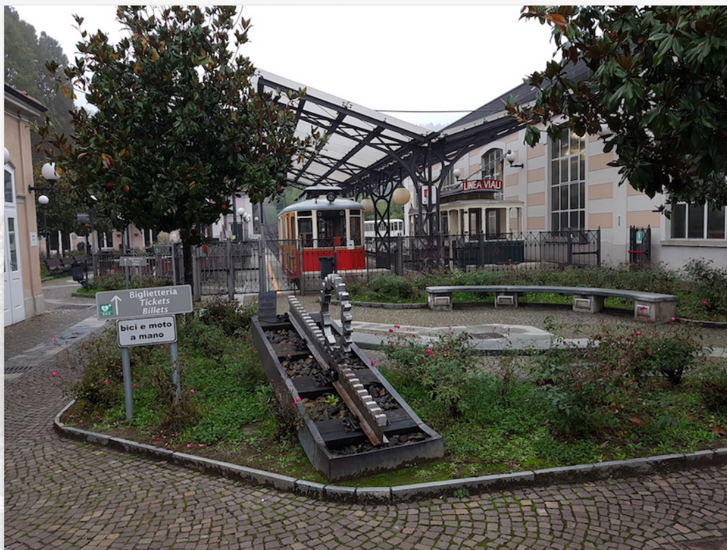
La véritable ligne à crémaillère Sassi-Superga. à l'entrée de la gare de Sassi, un morceau de crémaillère et un pignon montrent aux visiteurs la pente maximale de la ligne;
