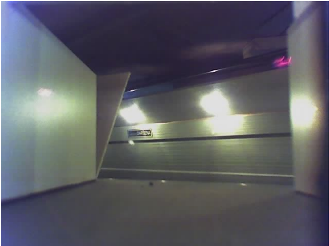
Unica immagine esistente della fermata sotterranea Gardesio Darsena
