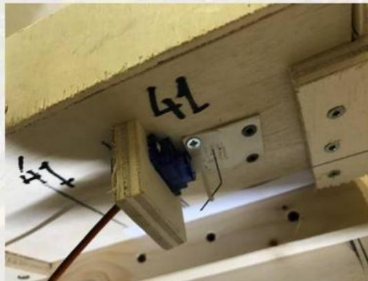
In corrispondenza del foro è installato un quadrato di forex spesso 2 mm, forato per permettere il passaggio dell'asta di azionamento. Il quadrato di forex forato è il fulcro della leva di attuazione che da una parte è collegata al deviatore e dall'altro al servo.
